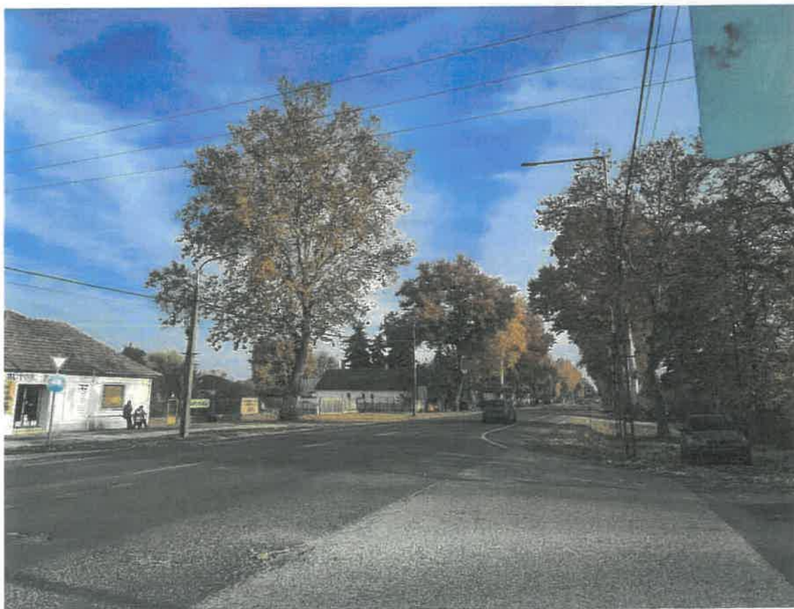
Több helyen nincsenek pótolva a hiányzó faegyedek. A platánok törzse általában túlnyúlik az elektromos légvezetéseken.
